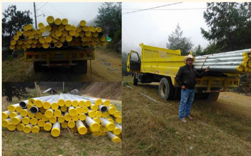
Figura 8. Entrega-recepción de material para la rehabilitación del SPV.
